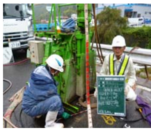
【施工立会の状況写真】
