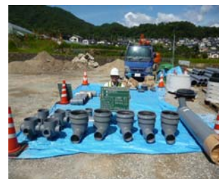
【材料立会の状況写真】
